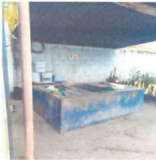
Foto1: sustitución pila, nivelada y con conexiones hidráulicas y colocación de cerámico
