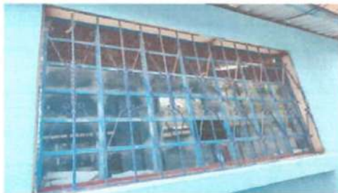
Foto 3: Sustitución de ventanas; sistema de apertura: Corredizas, Perfiles color blanco estandar, Material del marco: PVC Material de la ventana: Vidrio, sellado perimetral.
