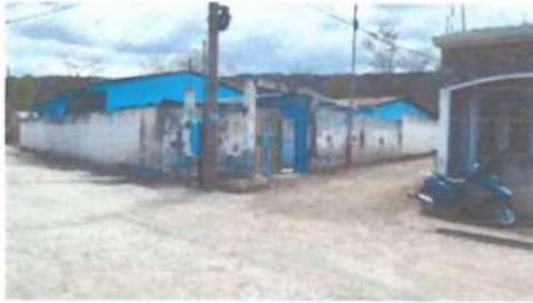
Foto 1: Preparación de la superficie y aplicación de pintura, en paredes interiores y exteriores del establecimiento y retoque de logo
