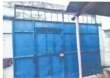
Foto 2: Sustitución de portón de ingreso, material: metálico, incluye: bisagras y sistemas de cierre.
