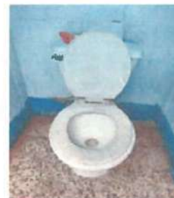
Foto 6: Sustitución de Sanitarios 2 pequeños y 1 grandes, accesorios y conexiones.
