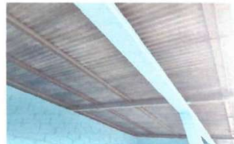
Foto 4: Sustitución de cubierta de techo con lámina galvanizada, Tipo de lamina: troquelada Calibre: 26, incluye: fijaciones y sellado en traslapes.
