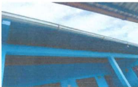
Foto 5: Sustitución de estructura metálica para soporte de cubierta de lámina incluyendo perfiles para vigas, travesaños, sujeta con tornillería; corte, soldadura y anclaje de la estructura portante.
